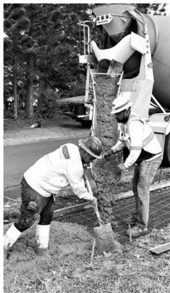
Peterson Bros.' work crew pours . . .
